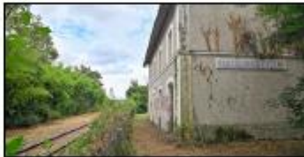
La gare de Castelnaud-Fayrac sera réhabilitée pour les navettes.
